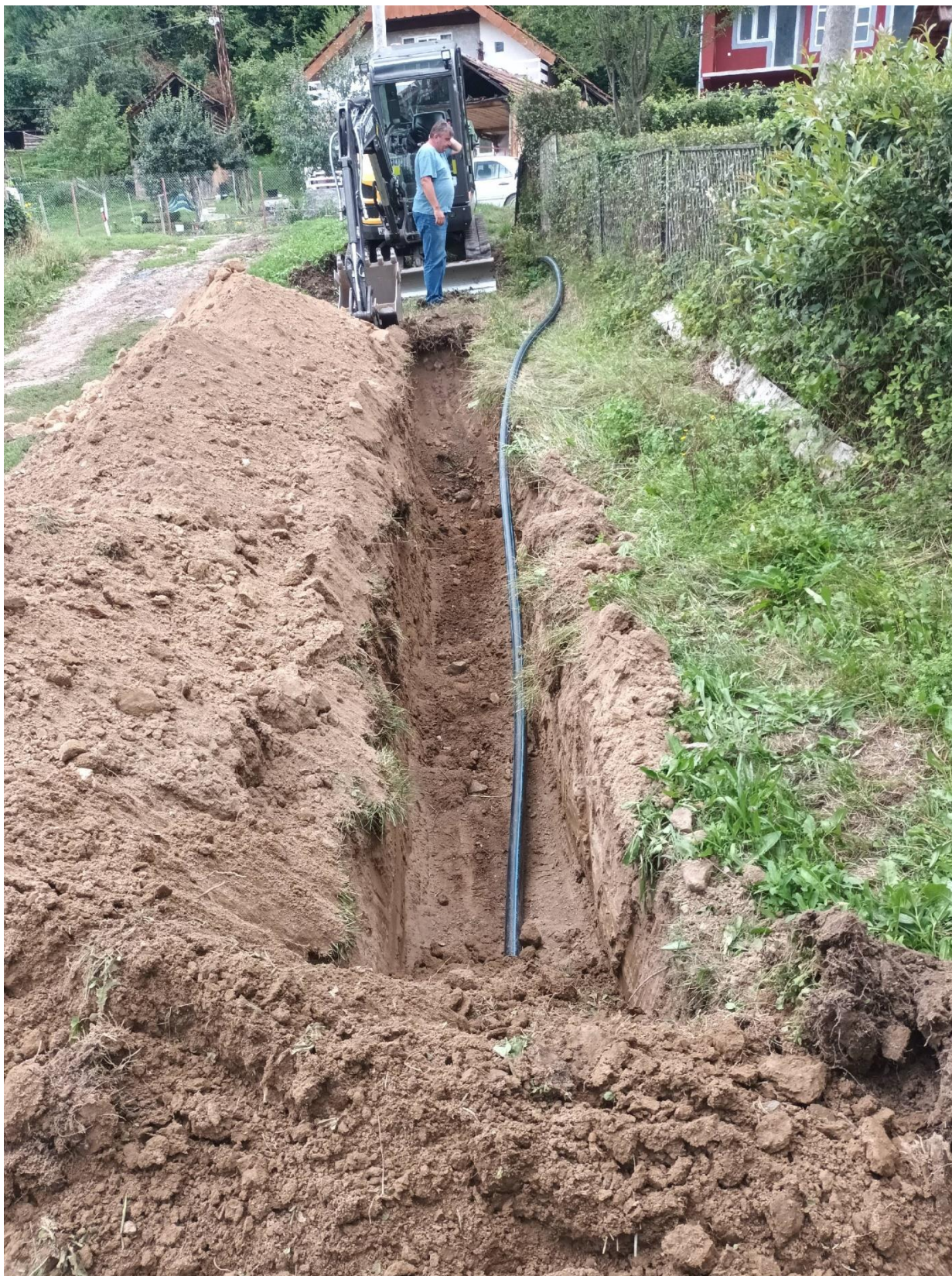
Polaganje vodovodnih cevi za vodosnabdevanje dela sela Mlekominci
