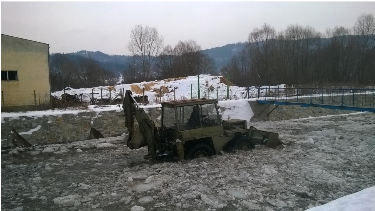
Pripremni radovi na sanaciji havarije na vodovodnoj liniji u zimskom periodu u koritu reke Dragovištice
