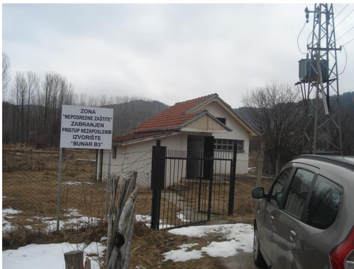
Pumpno postrojenje Bunara B-3 „Sred polje“.
