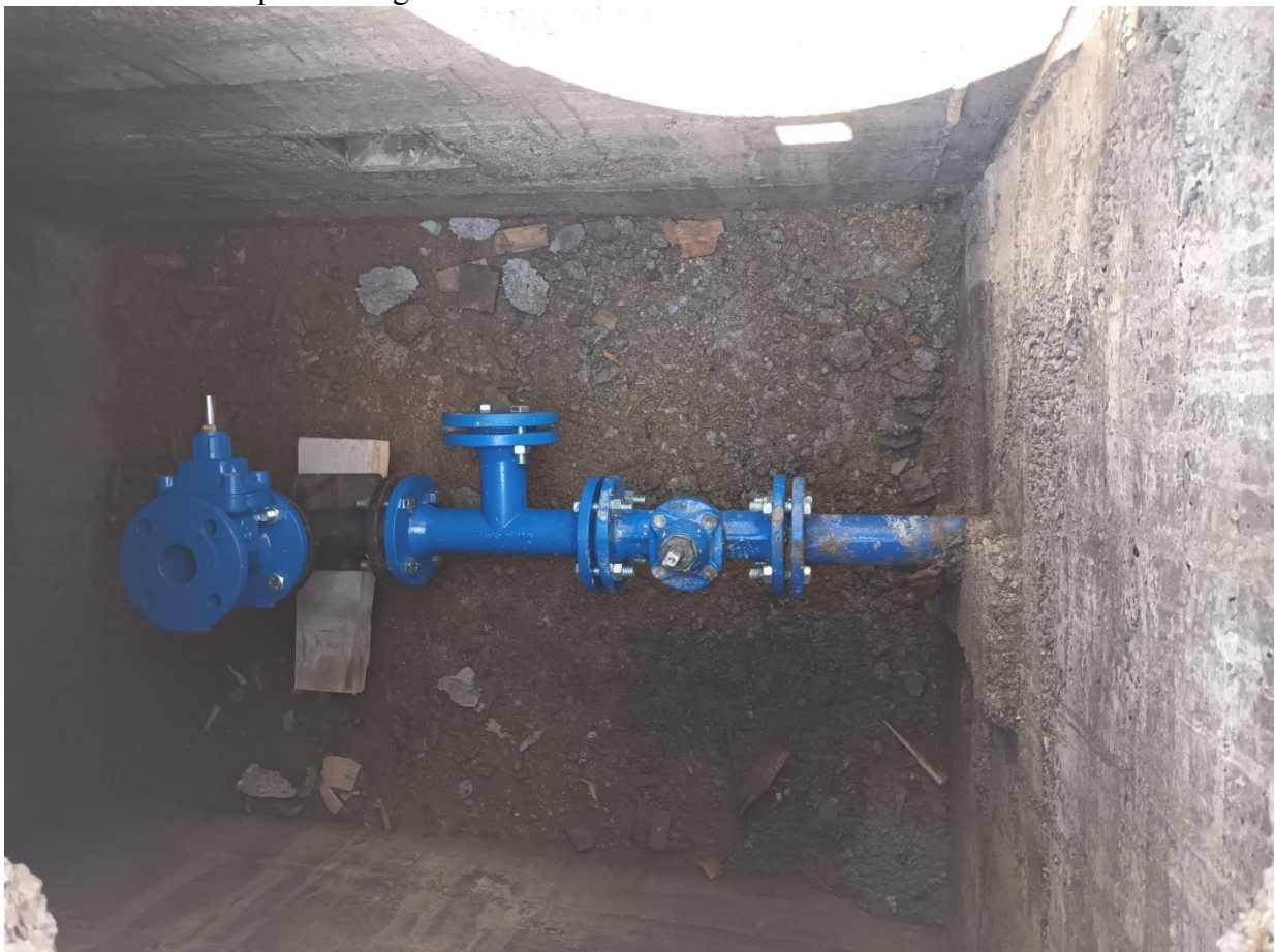
Tipiska završna šahta za izradu priključnih krakova I ugradnje vazdušnog ventila vodosnabdevanja dela sela Mlekominci
