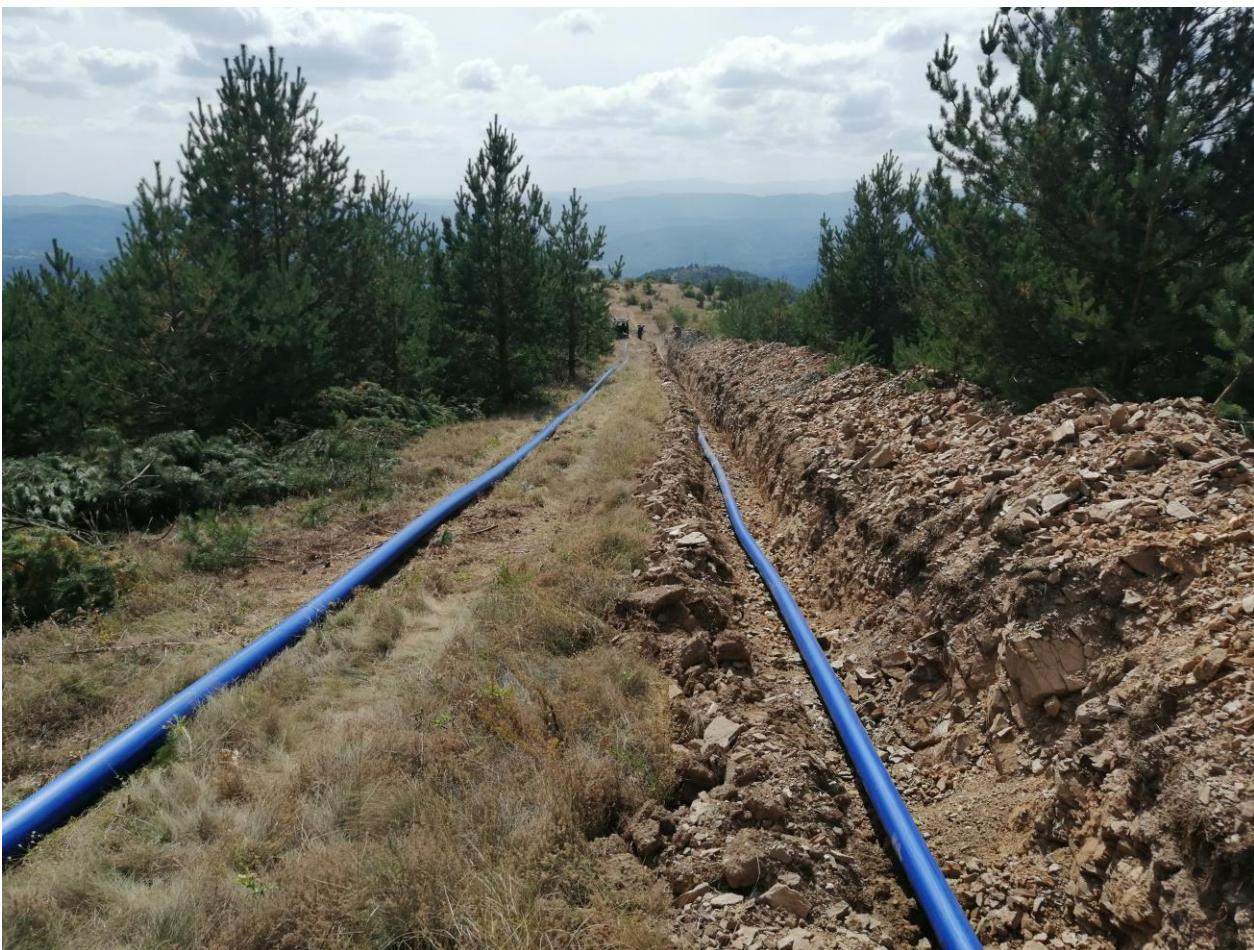
1. - Izgradnja dela novog sistema vodosnabdevanja sa izvorišta „Roda“ u pogledu dovoda vode DN 160 sa pretećim objektima prekidne komore, isppusti na dovodu i vazdušni ventrili na dovodu u ukupnoj dužini od oko 3.000 m1
